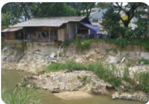
Rajah 2.3(h): Runtuhan Pelindungan Struktur
