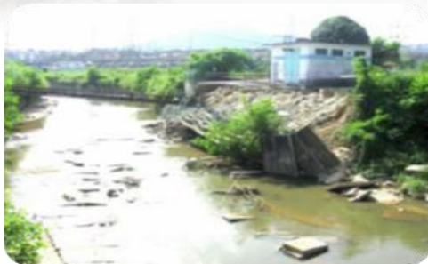
Rajah 2.3(c) Runtuhan Tebing /Dasar sungai
